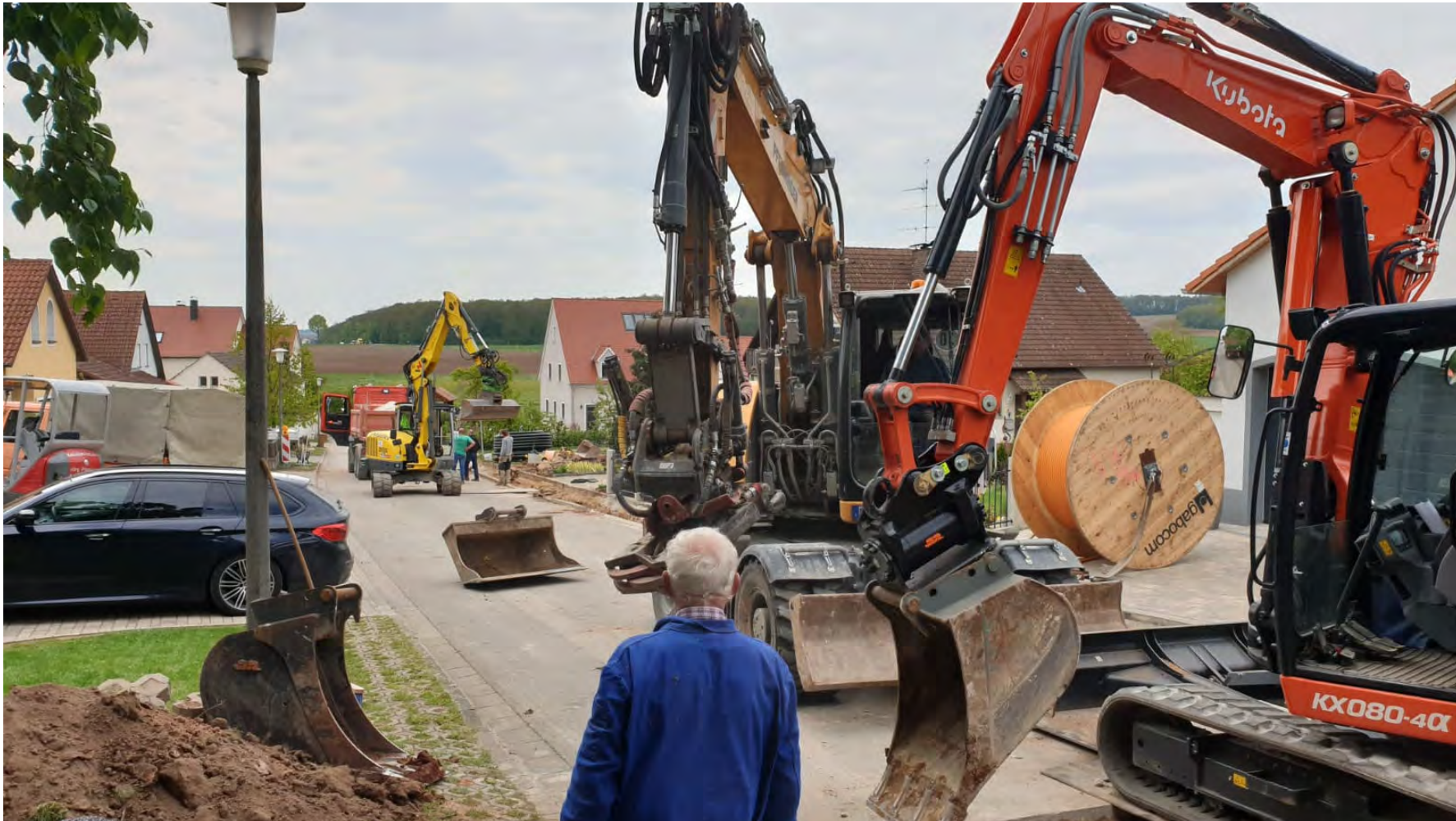
Rohrverlegung in offenen Graben.
