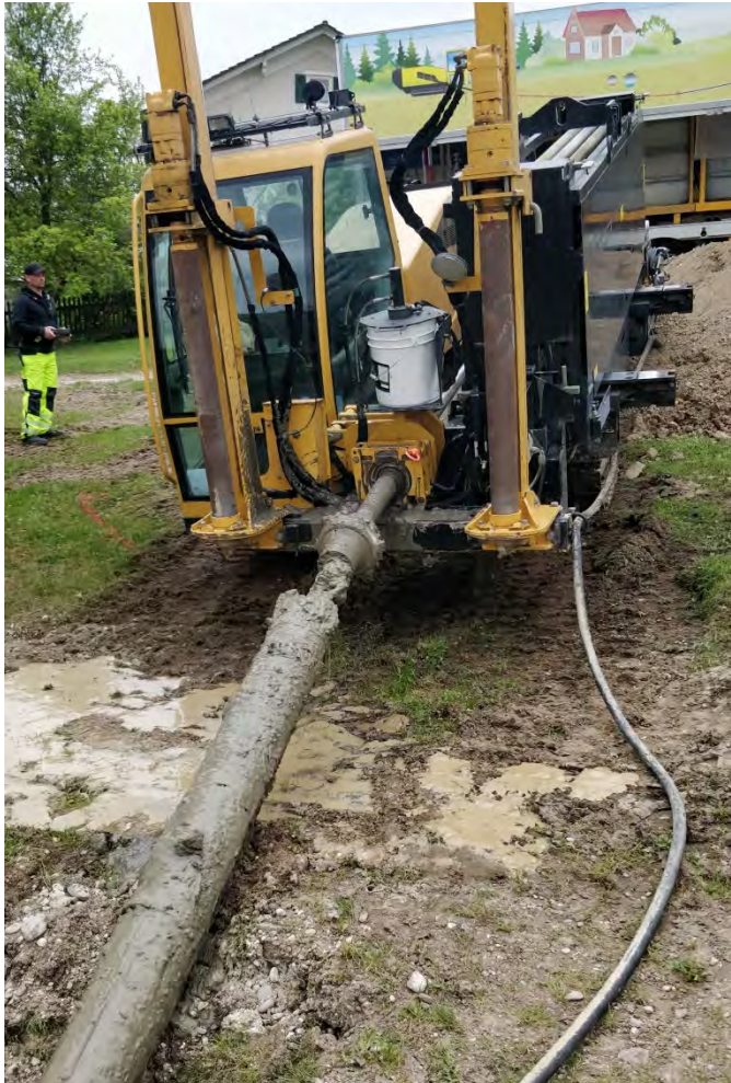
Grabenlose Verlegung im günstigen Spülbohrverfahren
