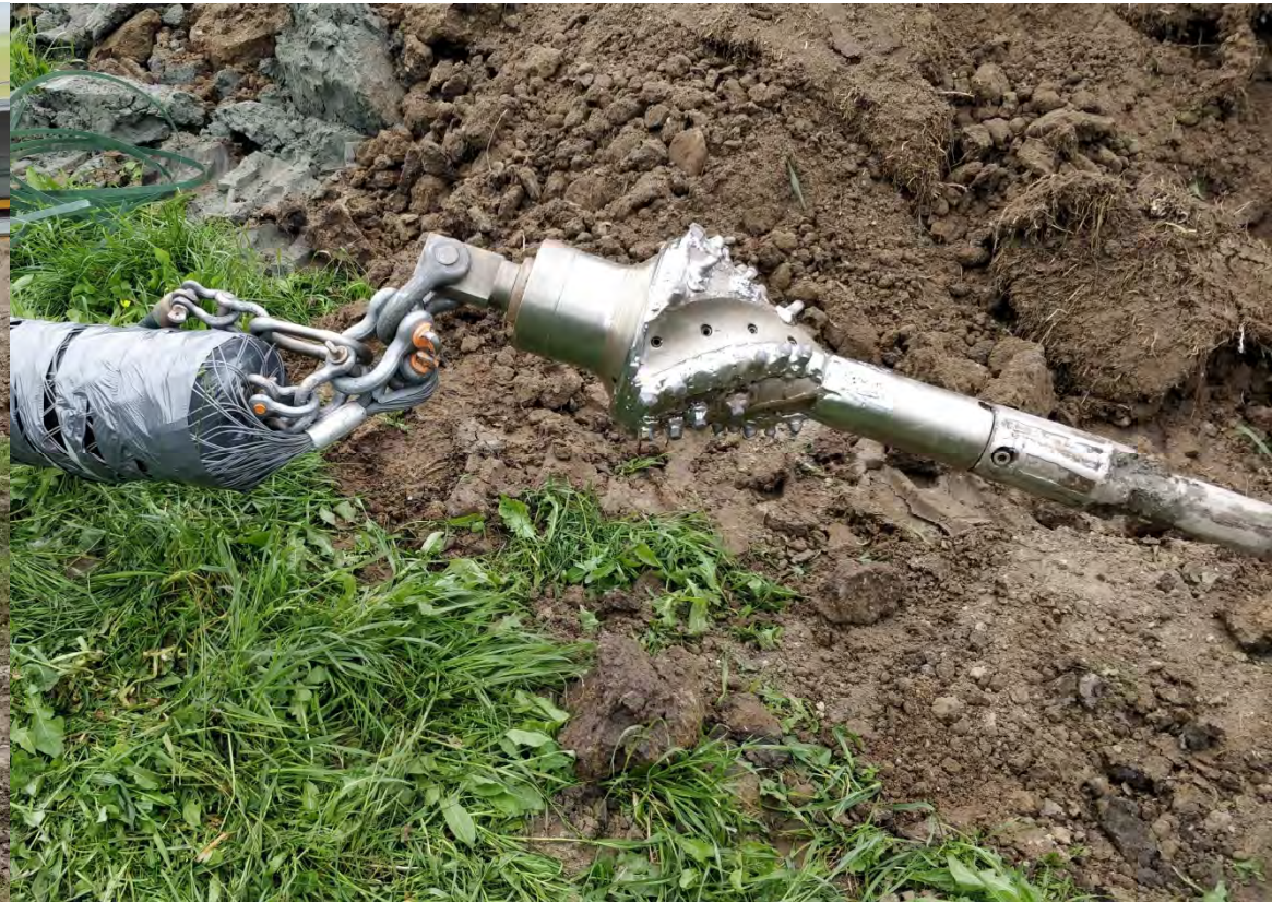
Grabenlose Verlegung im günstigen Spülbohrverfahren
