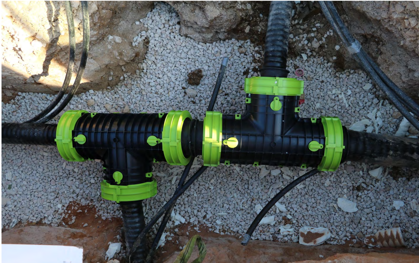
T-Stück im offenen Graben.
